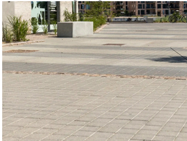
Belægningssten i beton med striber i chaussesten
